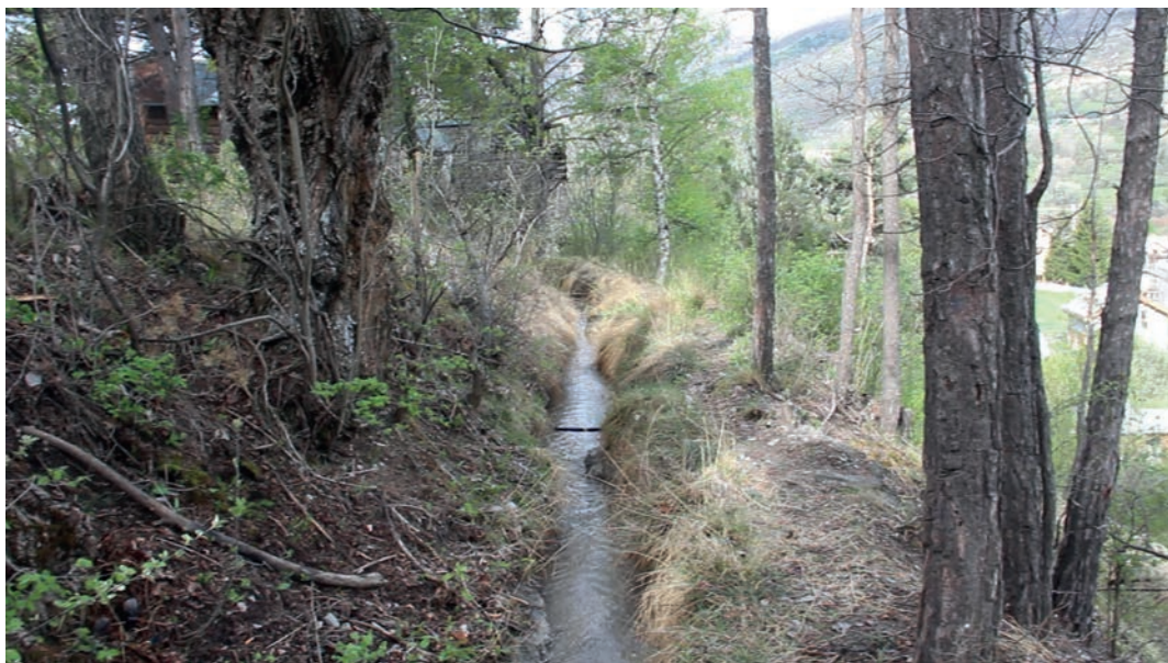
Fig. 1 Canal porteur mis en eau sur la pente de la montagne. © Epinoia/Salvo Manzone.
