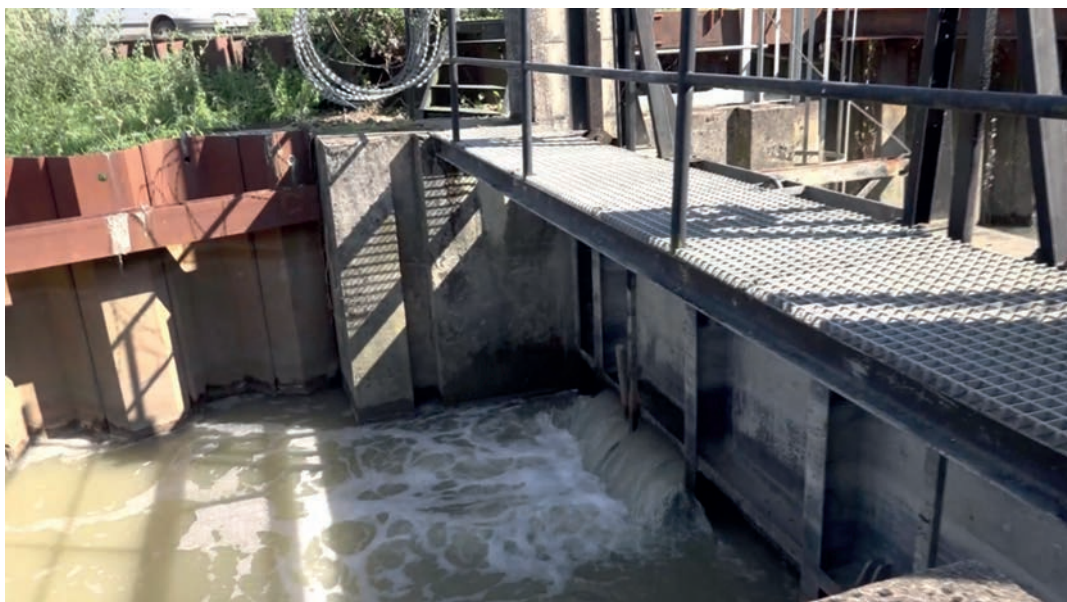
Fig. 7 Une vantelle ouverte sur la vanne de Cordemais permet, depuis l'estuaire, à la marée et aux sédiments de venir nourrir le marais du Lot en amont, une cale de bois posée par l'éclusier garde une ouverture permanente pour « tenir le niveau », et permet en même temps le passage des poissons. © Éric Collias, 6 septembre 2018.
