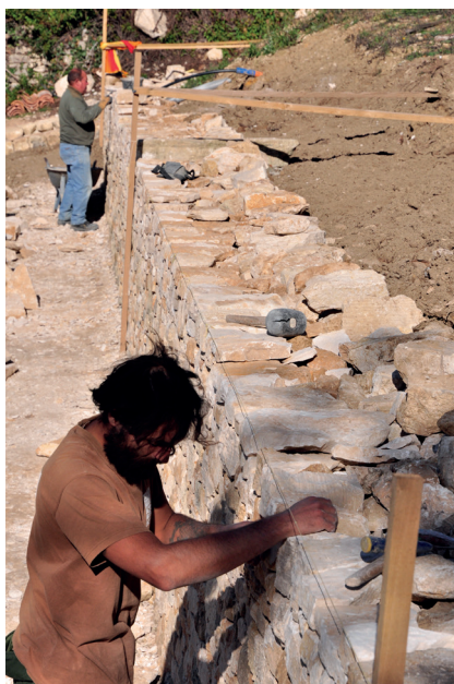
Fig. 8 Travaux dans le parking de Saignon (84). © Claire Cornu.
