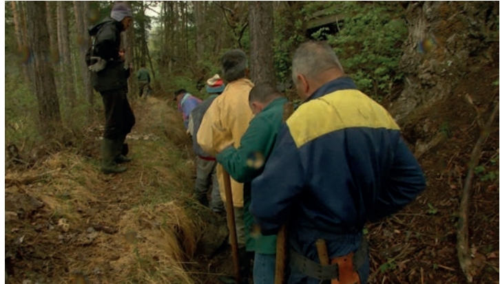
Fig. 4 Entretien et nettoyage des canaux avec pelles et râtaux. © Epinoia/Salvo Manzone.
