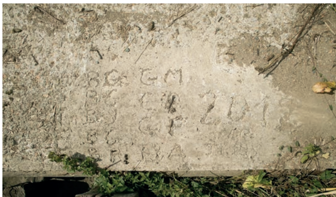
Fig. 10 ( ci-dessus ) Les initiales des éleveurs et chasseurs ayant participé à une corvée commune pour la construction de la passerelle du Tertre-Rouge qui relie l'île Pipy sont tracées dans le béton. © Éric Collias.
